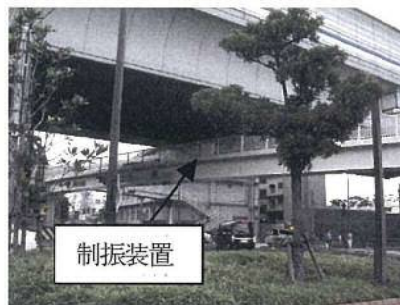
図11 A歩道橋 (TMD 設置後)
