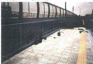
図8 M歩道橋 (新設橋)
