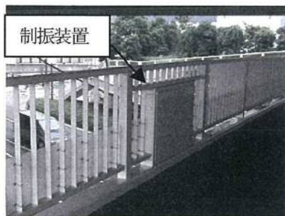
図12 高欄設置型 TMD
