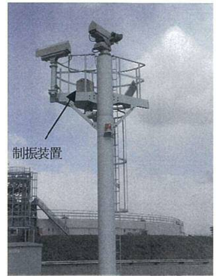
図5 監視カメラ柱
