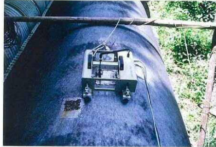
水圧鉄管への機構駆動部配置状況
