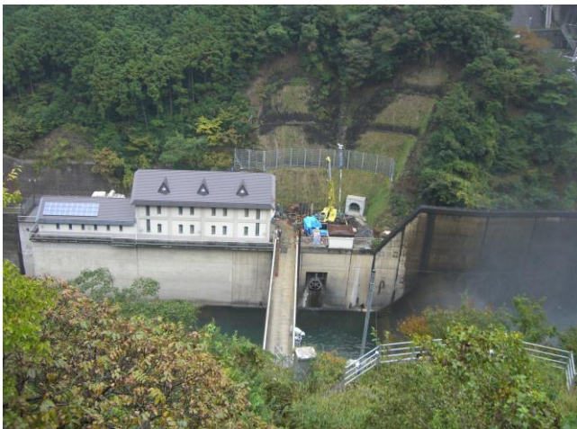
狭隘な施工条件
