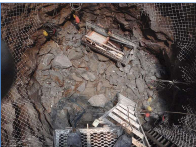
たて坑内 放電破碎 実施後
