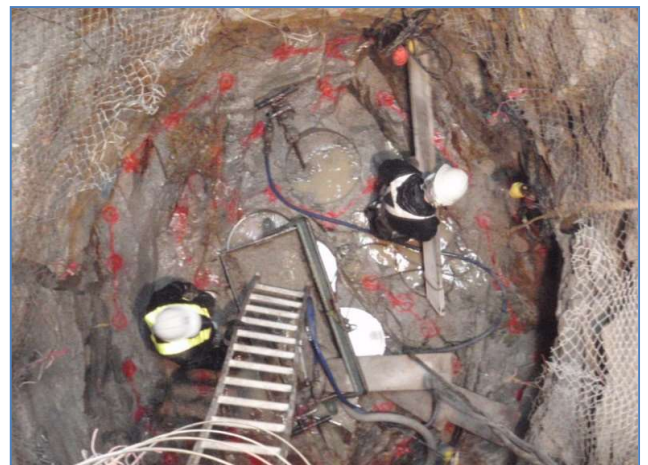
たて坑内 放電破碎作業 削孔前
