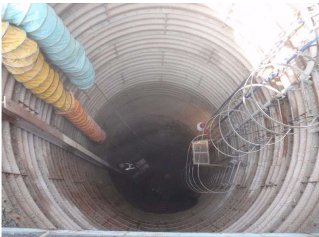
たて坑内 施工状況
