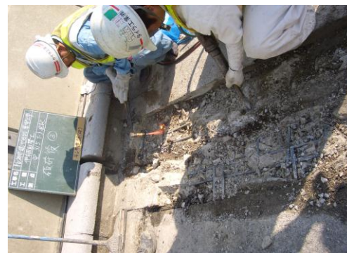
6 鉄筋ガス切断・破碎部整形
